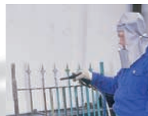
Gründliches und material- schonendes Sandstrahlen
