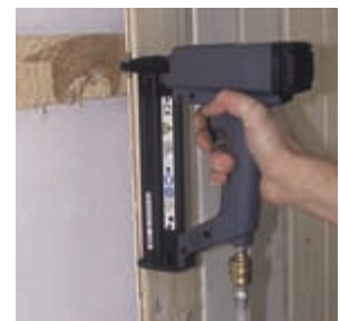
Zeitsparende Montage von Profilholzverkleidungen
