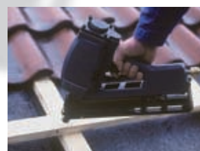
Rationelles Festnageln von Dachlatten
